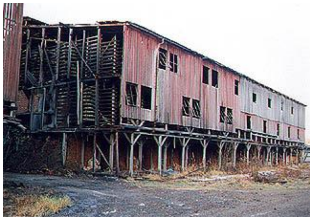
Tegelbruket i Gräsmyr, Nordmalings Kommun, Västerbotten
