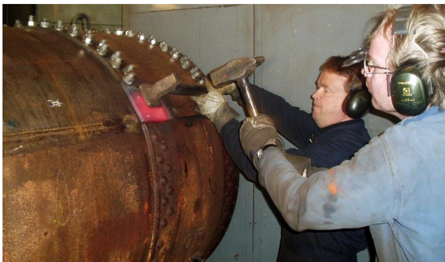
Justering av plåtanläggning med hjälp av slägga och sätthammare.
